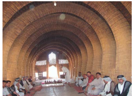
Abb. 2. Traditionelles Gästehaus der „Moor-Araber“, ausschließlich erbaut aus Schilfrohr. – Foto: Hassan Janali, U.S. Army Corps of Engineers, 2004; Wikimedia commons.
