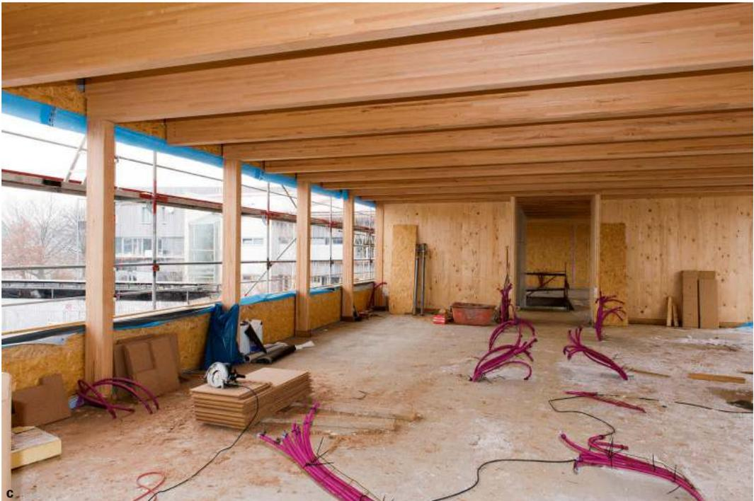
**Abb. 4.** Beispiele für innovative Holznutzungen: **a**, aus vorgefertigten Holzbauteilen errichtetes Wohnhaus in der »City of Wood«, Bad Aibling; **b**, T-Shirt aus Buchencellulose (Modal); **c**, Gebäudekonstruktion aus Buchen-Brettschichtholz, LWF Freising. – Fotos: a, c: HFM (R. Rosin, G. Weber-Blaschke); b: Fachschaft Forst, TUM.
